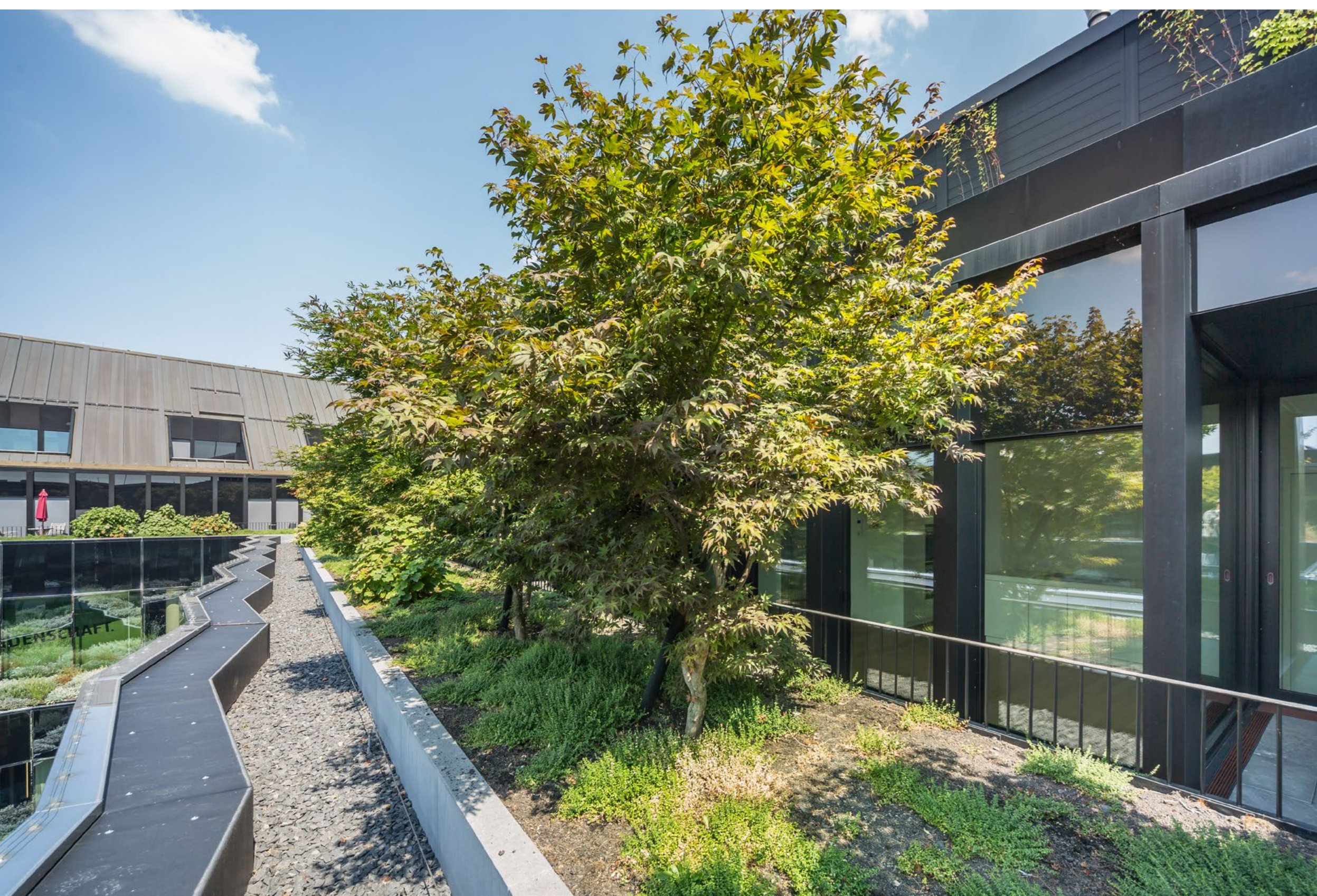
Innenhof des Joseph Pschorr Haus
